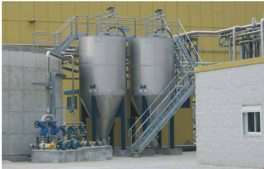
Безнапорный самопромывной фильтр Omegafilter для очистки возвращаемой или сбрасываемой воды.
