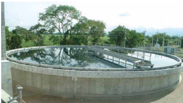
Комплектная линия с двумя ступенями: реактор MBBR + реактор с активным илом, и частичным рециклом очищенной воды
