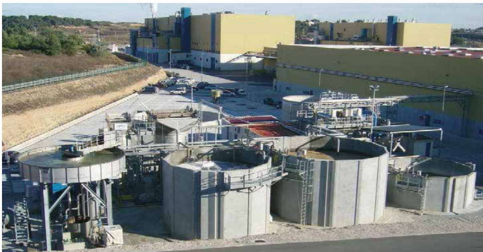
Комплектная линия с двумя ступенями: реактор MBBR + реактор с активным илом, и частичным рециклом очищенной воды
