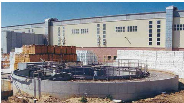
Реактор с прикрепленной микрофлорой в бетонном резервуаре
