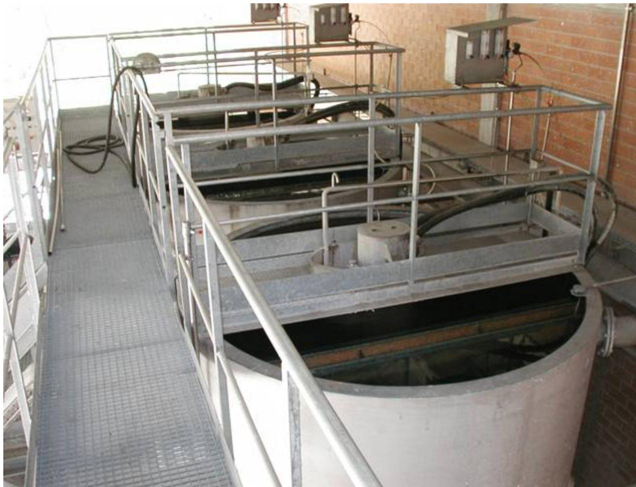
**3 фильтра OMEGAFILTER для доочистки осветленной воды бумажной фабрики. Италия.**
