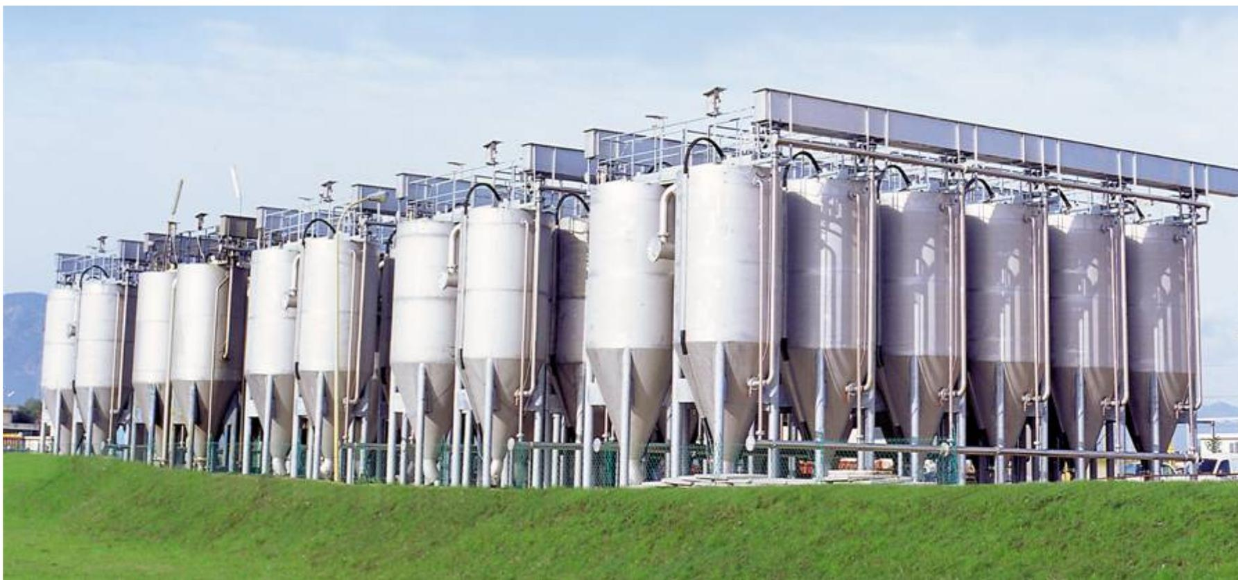
**60 фильтров OMEGAFILTER. Доочистка сточных вод. Остров Сардиния.**
