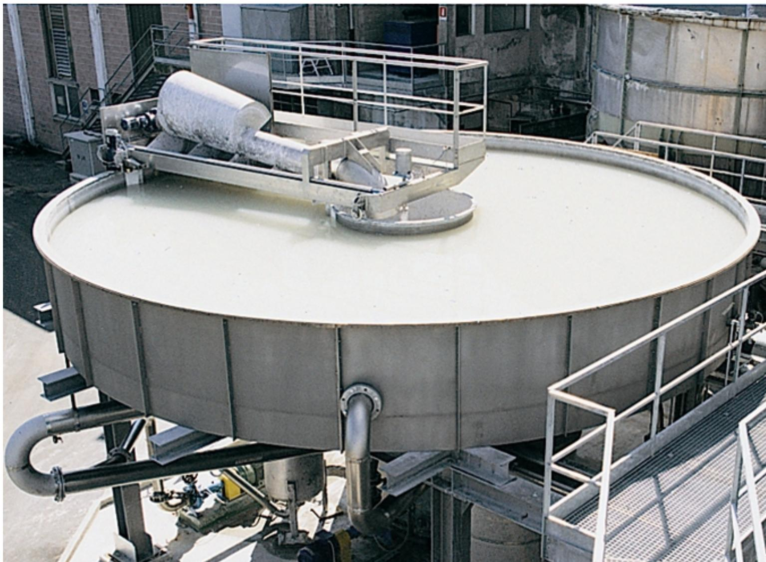
**2 флотатора DELTAFLOAT 42 и 2 фильтра OMEGAFILTER на бумажной фабрике, Италия**
