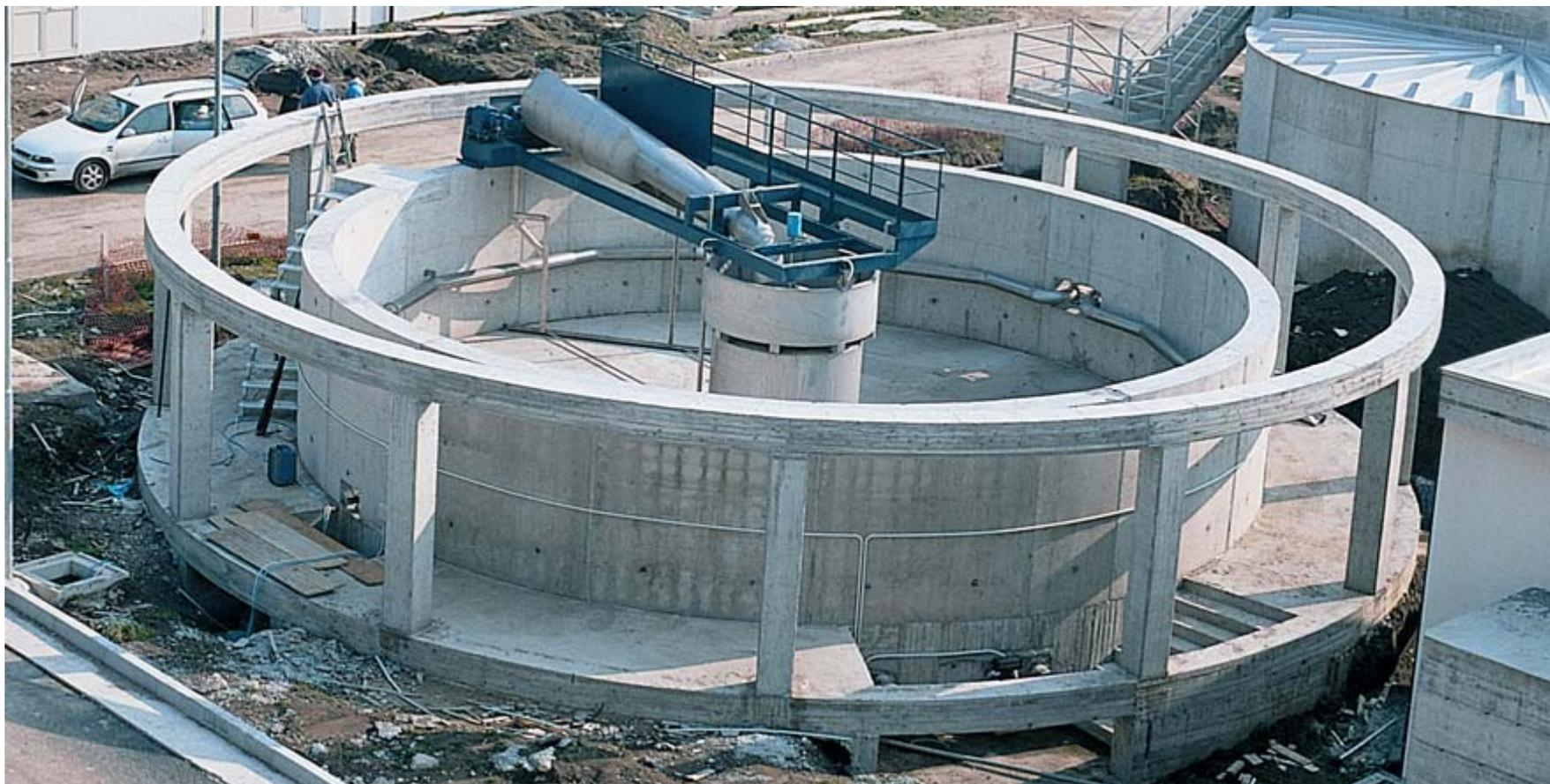
**Установка SEDIDELTAFLOAT в бетонном корпусе.**
