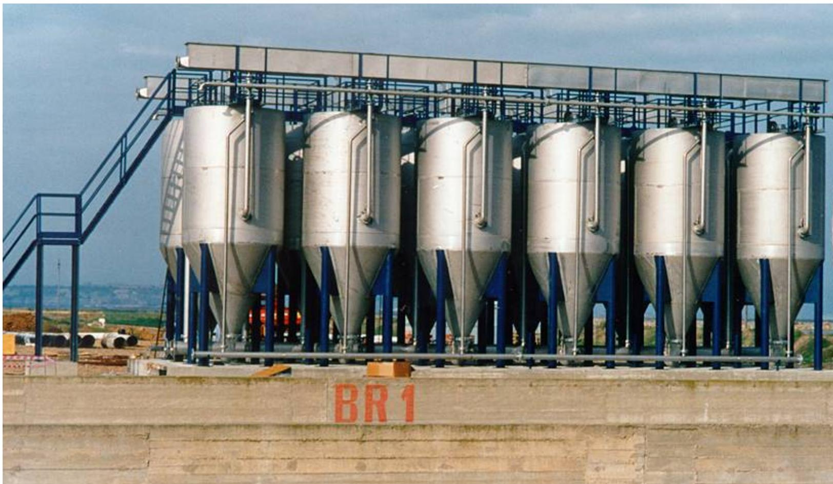
**12 фильтров OMEGAFILTER . Доочистка сточных вод.**
