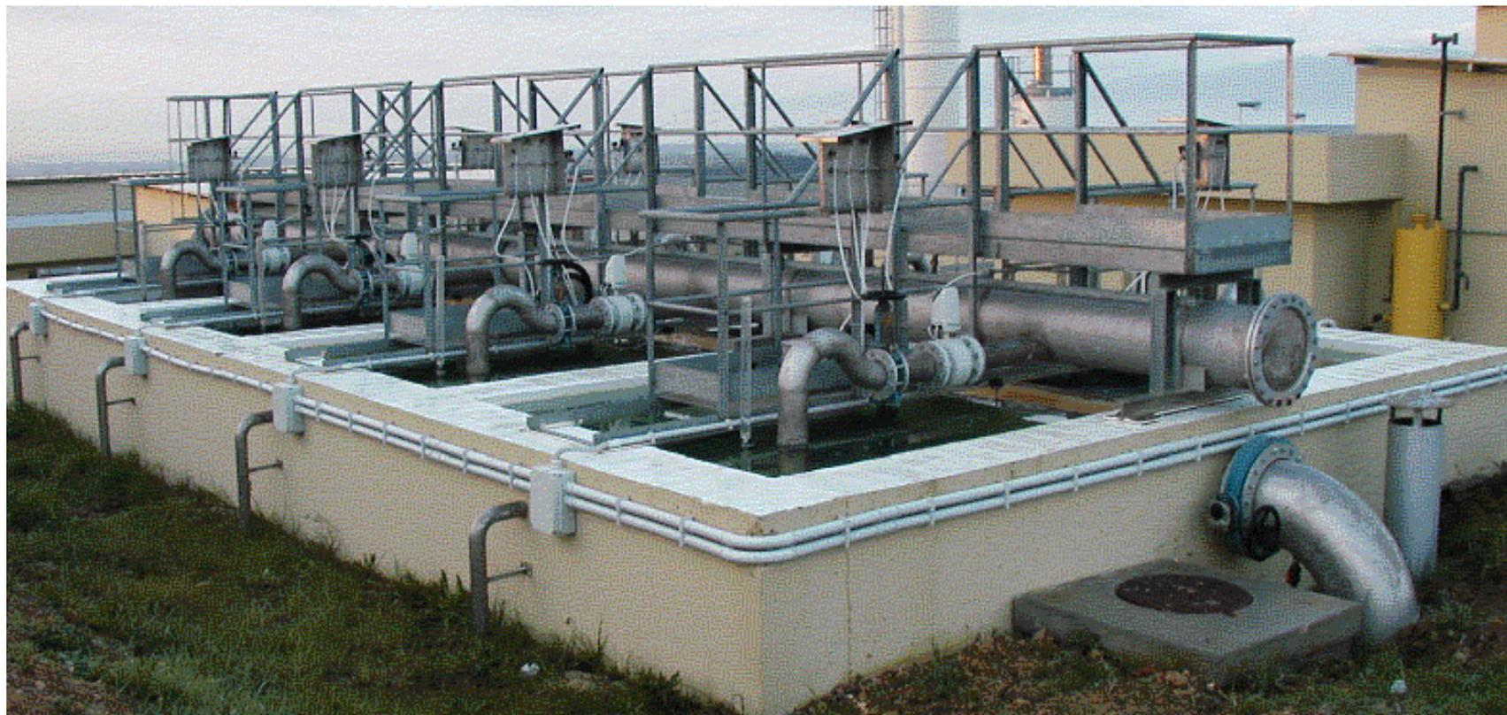
**8 фильтров OMEGAFILTER в бетонном корпусе.**
